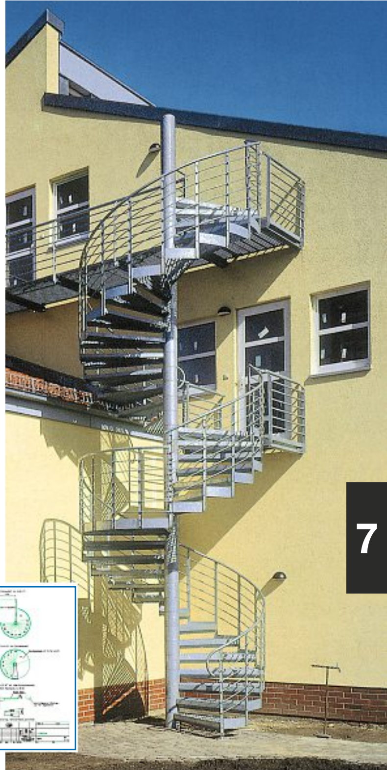
Abb. 2 ... mit 6 Kniegurten, Rohrhandlauf, linksgewendelt (Berlin)
